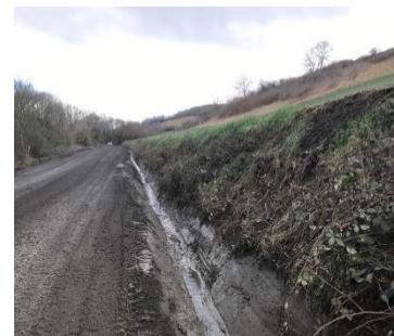
Route de la carrière
